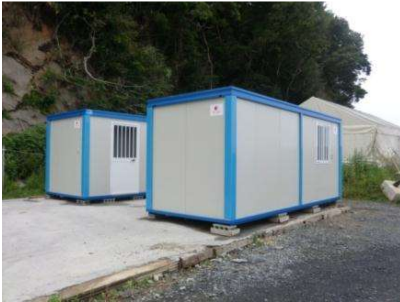
作業小屋や休憩所として役立てられるコンテナハウス (気仙沼にて、7月14日設置)
