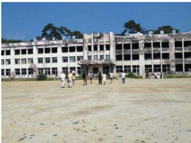
津波で破壊された石巻市立門脇小学校の跡を訪れ、言葉もなく、ただ頭を下げる参加者たち (2012年8月27日)
